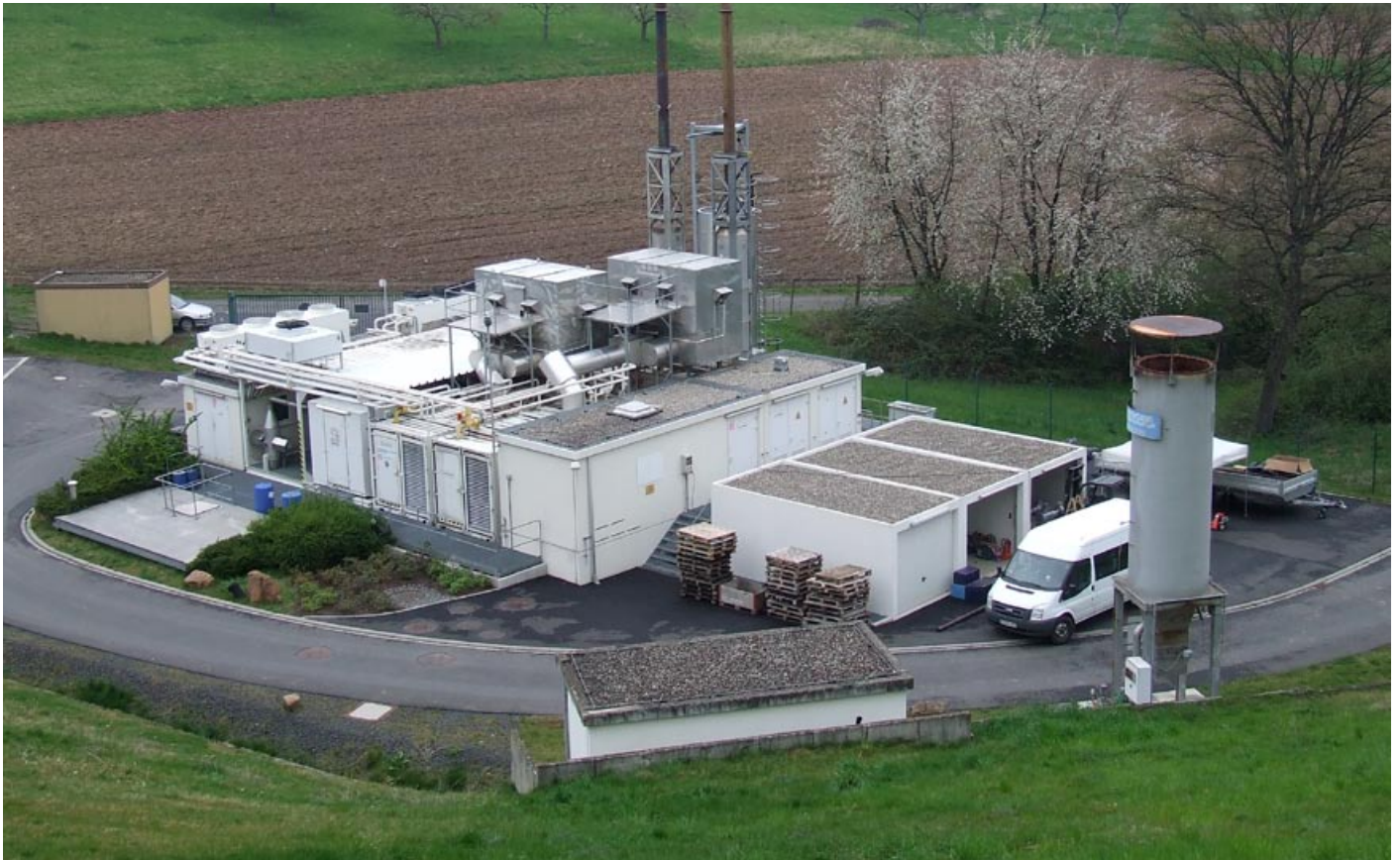
Abb. 1: Das Deponiegaskraftwerk in Gelnhausen-Hailer.
