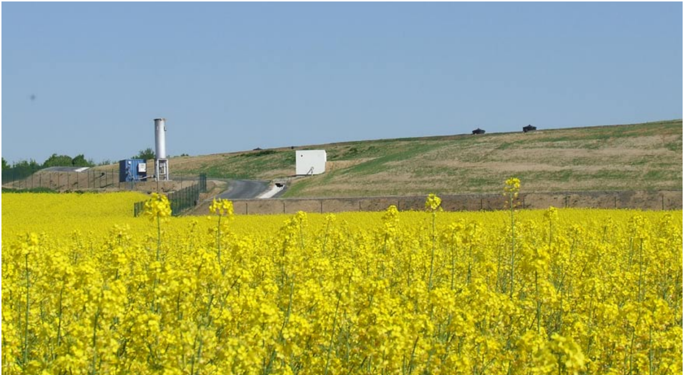
Abb. 1: Altdeponie Bruchköbel kurz nach Abschluss der Sanierungsarbeiten
