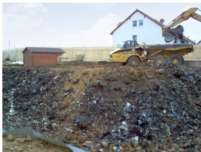
Abb. 4: Abfall wird nicht wieder zu Erde! Umlagerung von 30 Jahre altem Müll bei der Sicherung einer Altablagerung 65.000 Quadratmeter großen Oberflächenabdichtung versehen.
