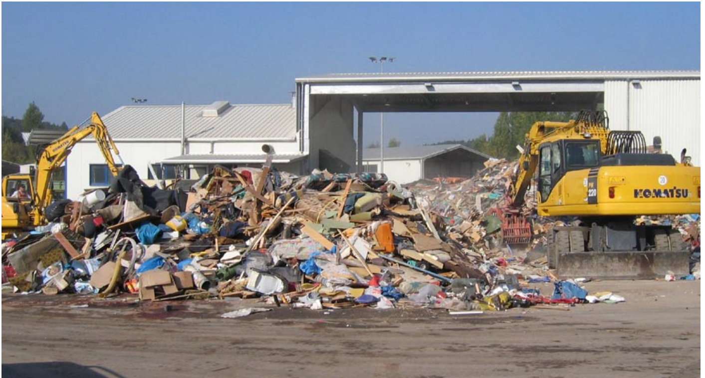
Abb. 1: Vorsortieren des Sperrmülls mit dem Greifbagger.
